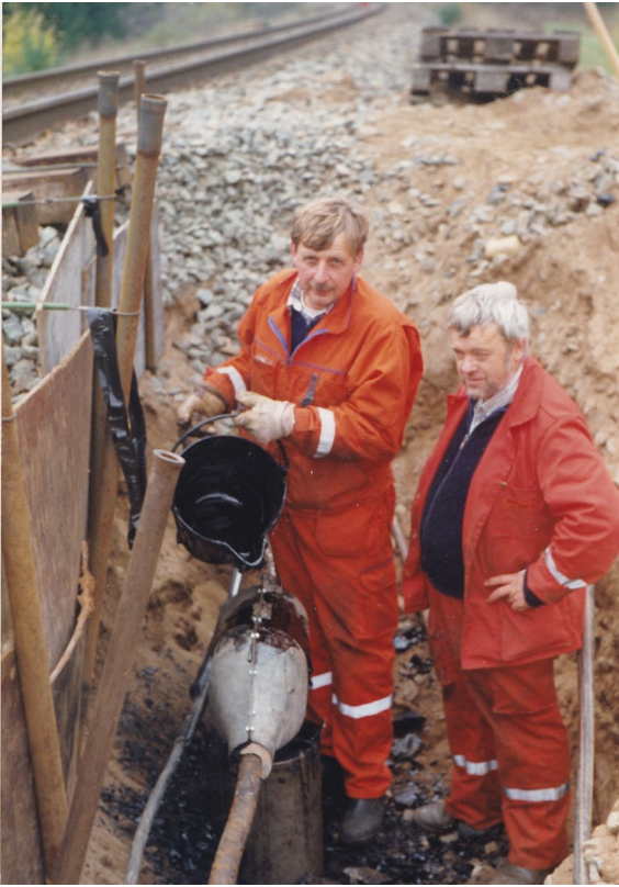
Jan Persson och Åke Artursson fyller en skarvbox på Herrijungkabeln med tjära
